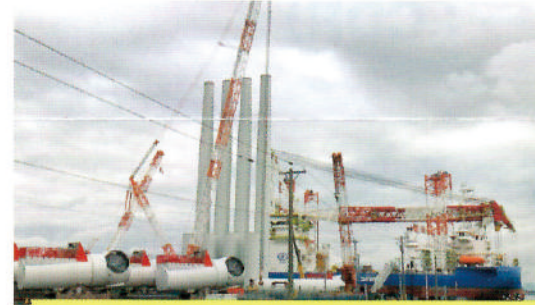
洋上風力発電工事現場（石狩湾新港）
