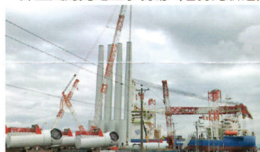
洋上風力発電工事現場（石狩湾新港）
